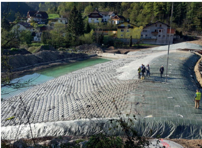
SCHOELLKOPF Coffrage Incomat - Treillis de coffrage en béton pour les ouvrages hydrauliques et la protection contre les inondations
