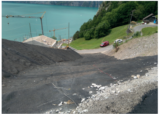
SCHOELLKOPF Géogrille Fortrac 3D – armature anti glisse tridimensionnelle
