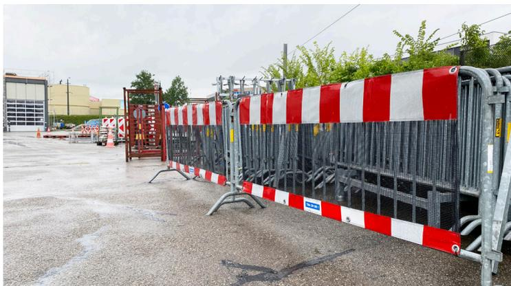
Die Absperrschranke ist 2,20 m lang und geeignet zur Befestigung an 2 m hohen oder halbhohen Zaunelementen. Sie ist die leichte und komfortable Alternative zu Absperrgittern aus Kunststoff.
